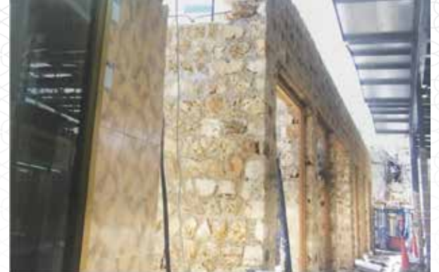
سوق صقر أثناء الترميم
