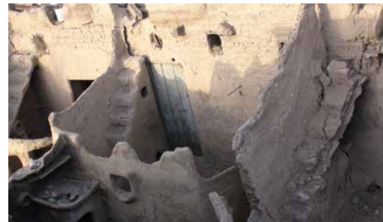
الجدران الداخلية وغرف المنزل الطيني
