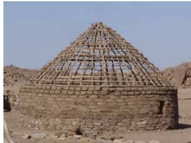
صورة رقم (2): الحائط الدائري من الطوب اللبن، وبناء الهيكل العلوي من الحطب والقنا في شكل مخروطي.
