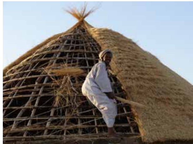
صورة رقم (3): الجرفي يقوم بتغطية هيكل الحطب والقنا بالقش، باستخدام أداة المُثْقَالَة.
